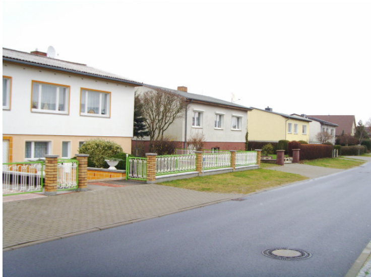
Vorhandene Gebäude im WA 2, hier: Riedenweg
