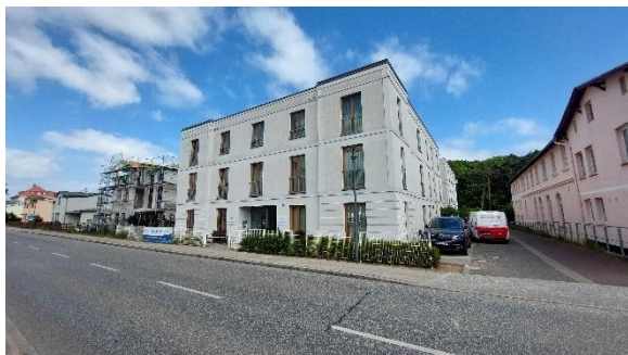
Gebäude westlich des Plangebietes
