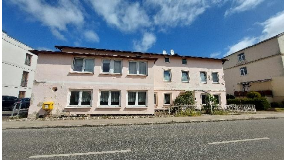
Gebäude in der Neuen Reihe 17, Vorderansicht
