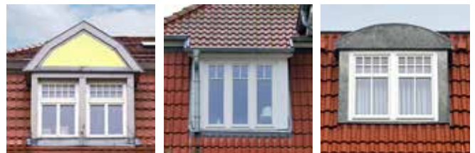
Links: Giebelgaube auf Mansarddach mit Biberschwänzen Mitte: Die Dachfläche des oberen Mansarddaches ist folgerichtig als Schleppdach über die Gaube vorgezogen. Rechts: Gaube mit Zinkblechverkleidung und Segmentbogen als oberem Abschluss.
