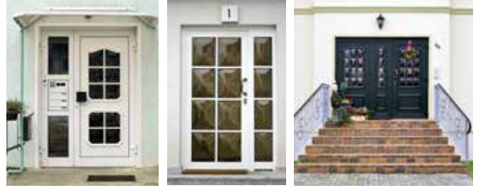
Weiße Kunststofftüren, getöntes Glas und Wölbglasscheiben passen nicht in das Stadtbild. Rechts: Türöffnungen sollen keine liegenden Formate haben.
