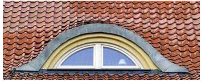
Fledermausgauben finden sich häufig auf Dächern mit Biberschwanzeindeckung, hier auf einem S-Pfannendach.
