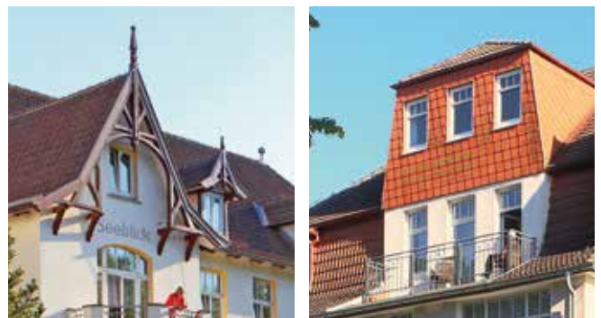
Links: Giebelgaube, zur Belichtung und zur Dekoration. Rechts: Mit der Verschindelung wurde vergeblich versucht, die viel zu große Gaube der Dachfläche anzupassen.
