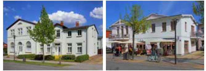
Der fünfachsige Ursprungsbau wurde jeweils um einen giebelständigen, eigenen Gebäudeteil in der Straßenflucht erweitert. So blieb der ursprüngliche Gebäudetyp ablesbar.
