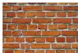
Einige wenige Gebäude wurden aus Backstein gemauert. Sie sollen erhalten bleiben, aber auch weiterhin eine Ausnahme bilden.
