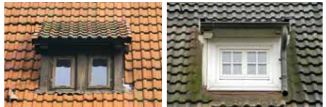
Die Schleppgaube ist mit dem gleichen Ziegelmaterial eingedeckt wie das Hauptdach. Schleppgaube auf einem mit Betondachsteinen eingedeckten Dach.
