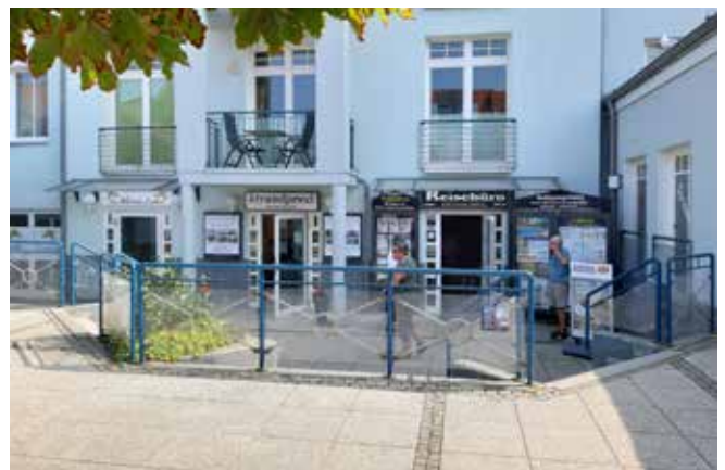
Fassade und Vorfläche der Gebäude werden von der Vielzahl der unterschiedlichen Werbeträger dominiert. Schilder, Beschriftung, Aufsteller und Schaukästen scheinen miteinander und mit den Aufenthaltsflächen zu konkurrieren.
