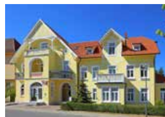
Das Dach des Ursprungsbaues war zur Entstehungszeit ebenfalls flach geneigt und wurde um ein Dachgeschoss erweitert.
