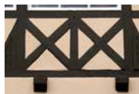
Fachwerkelemente in der Putzfassade
