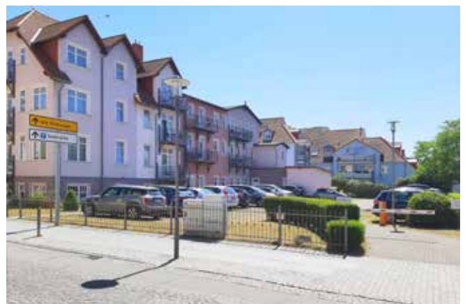
Die Grundstückseinfriedung ist zur Abschirmung der Stellplätze nicht ausreichend. Hier fehlt der Sichtschutz durch einen Gehölzstreifen, eine höhere Hecke oder eine Berankung eines höheren Zaunes.
