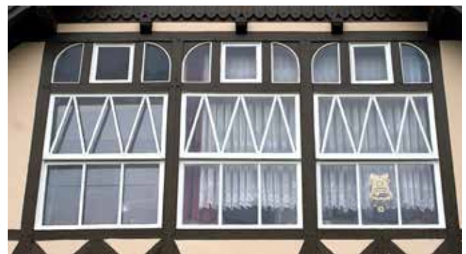
Die Nutzung der Veranden beschränkte sich früher auf die Sommermonate. Die Sprossenprofile der einfachverglasten Fenster waren sehr filigran.
