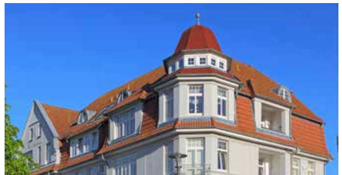
Oben: Die Gauben im zweiten Dachgeschoss sind behutsam in die Dachfläche integriert. Trotz Verwendung unterschiedlicher Gaubenformen und Gestaltungselemente wirkt die Dachfläche harmonisch.
